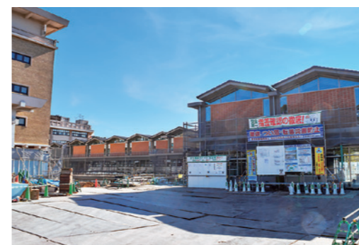
現在工事中の新校舎 (2020年11月現在)
