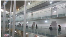
内装工事が進んでいます。
