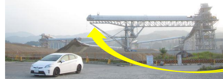
山から土を運び、 土地の高さを4~5mかさ 上げしている様子
