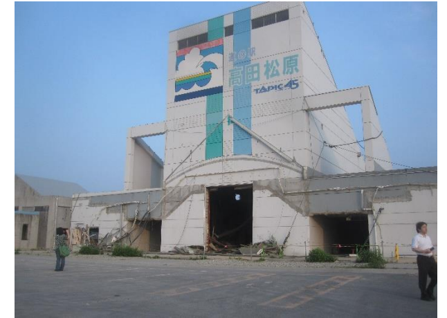
震災遺構として残される 高田松原の道の駅
